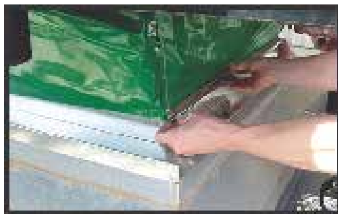
Ajuste la transición del conducto flexible al cuentagotas del conducto.
