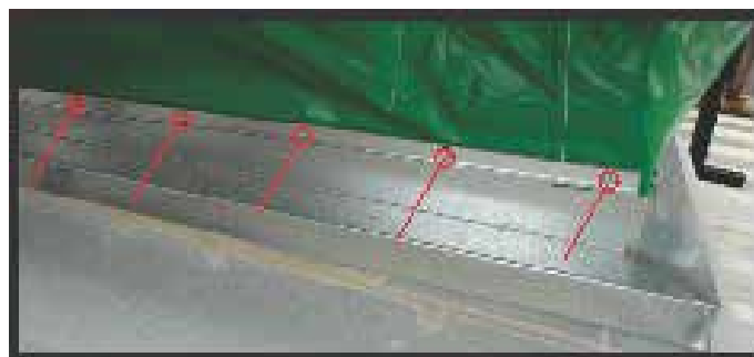
Fije el conducto flexible con tiras de sujeción y tornillos autorroscantes.
